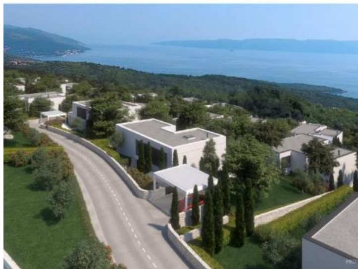
CON VILLAS: AERIAL
